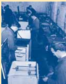
Umstellung der Gasgeräte von Stadtgas auf Erdgas
