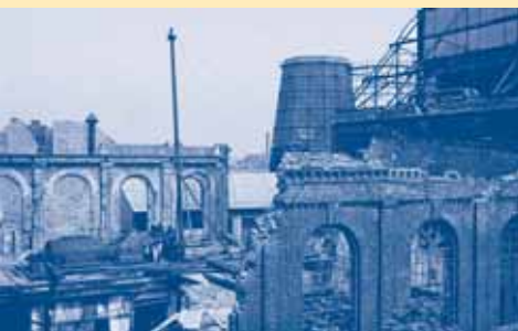
Das Maschinenhaus des E-Werks liegt in Schutt und Asche, 1947.
