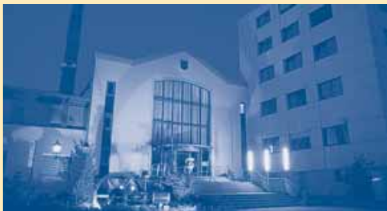
Kundenzentrum Historische Turbinenhalle
